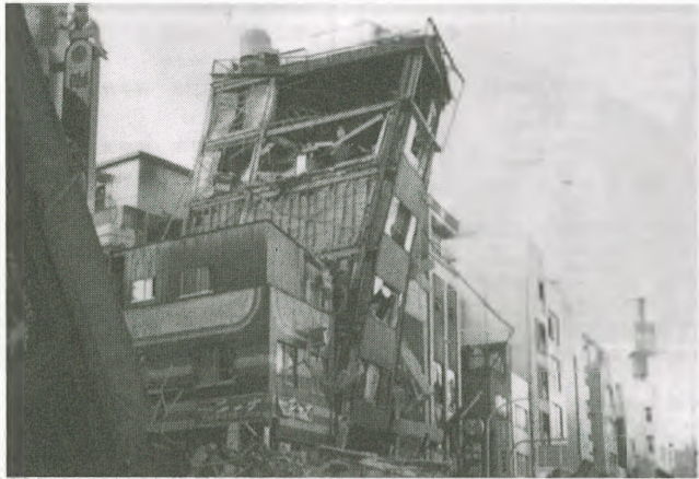
●神戶的房屋已受地震毀壞不堪了。
