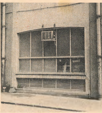
北角模範里內工廠冷氣滴水
