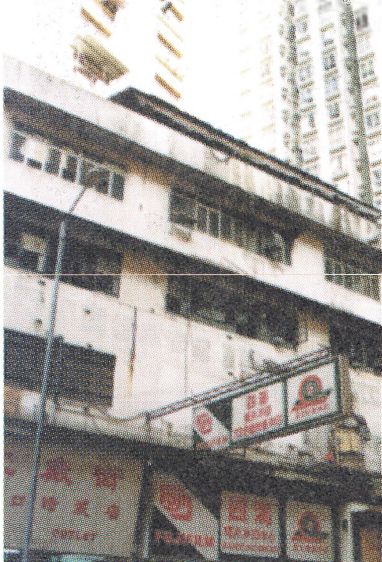
合隆工廠大廈的三級大火，引起市民對消防問題的關注。
