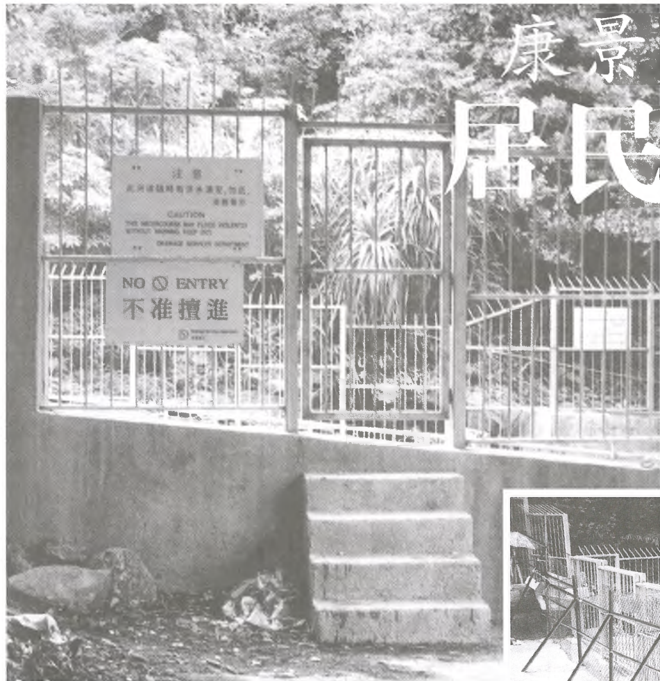
■居民：圍欄經不起風雨的考驗，早前黑色暴雨後，圍欄便告毀壞。
